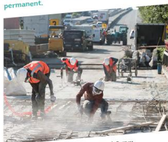
Rénovation du pont de l'A6 sur l'Esnonne à Ormoy.
